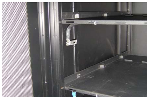
层间线走线图（在托盘前端内走线）
